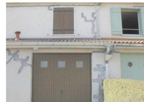
Un conséquence du retrait-gonflement des argiles : la fissuration de la structure des bâtiments
